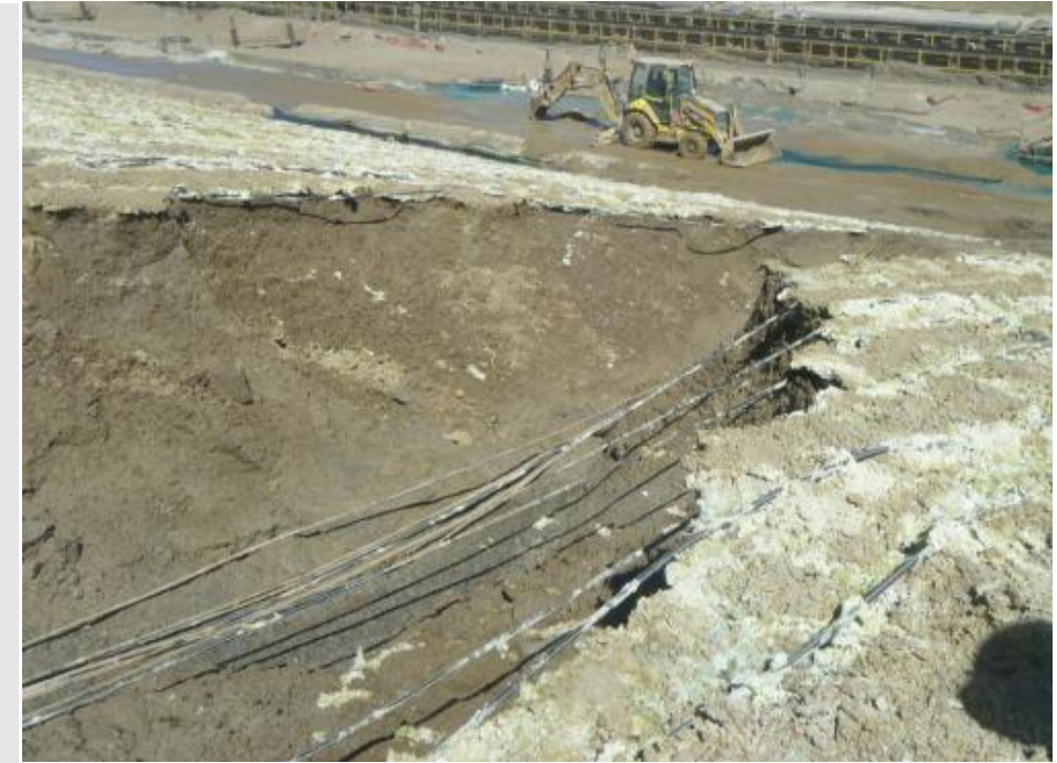
Deslizamiento en los taludes por efecto de riego en exceso o mal drenaje del depósito.
